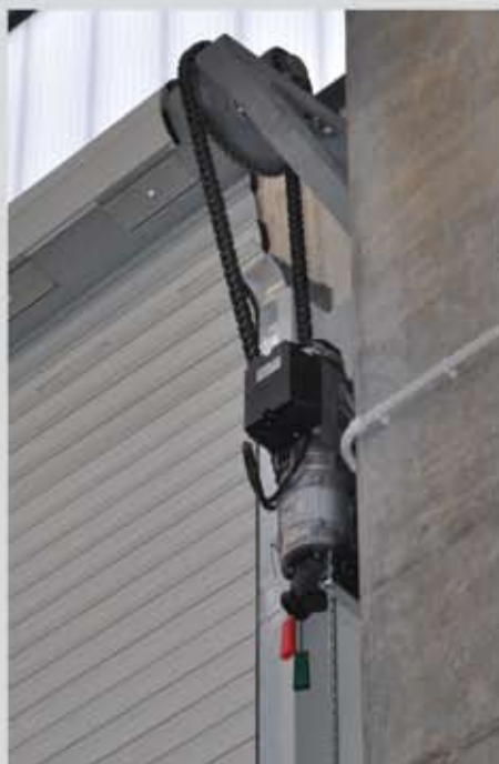
Motore laterale con rinvio a catena
