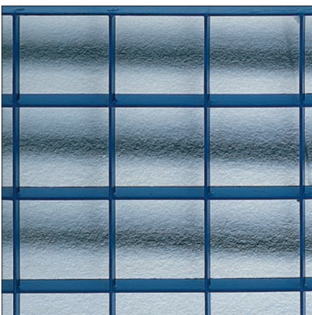
Particolare del rivestimento con grigliato elettrosaldato zincato a maglia 77x77 piatto 25x2. Aerazione pari a circa l' 80/85% della superficie del manto.
