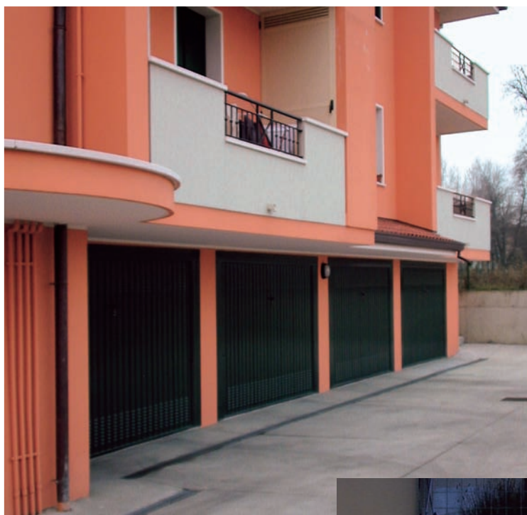
Chiusura box esterni in una palazzina residenziale.
